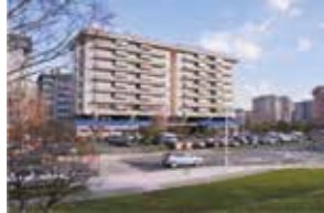
Losán Gestión Head Offices, A Coruña (Spain)
